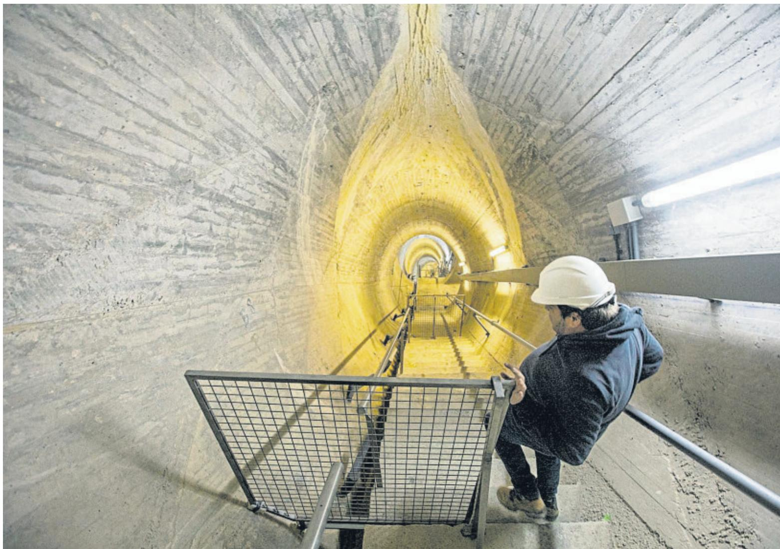
tros de profundidad), con los que se puede observar con detalle el más mínimo desplazamiento que se produzca en la pared de la presa.
